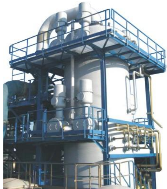
Bild 1: Nass-Elektrofilter (WESP)
